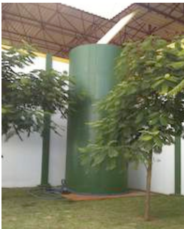
Foto 1– Reservatório de 42.000 litros que armazena água da chuva.
