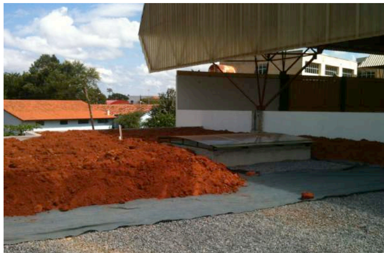
Foto 6 – Construção do telhado verde utilizando terra retirada do buraco da piscina.
