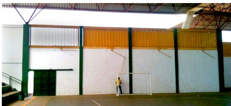
Foto 3 – Foto dos brises da fachada Leste. Área de brises: 82m 2 de cada fachada.
