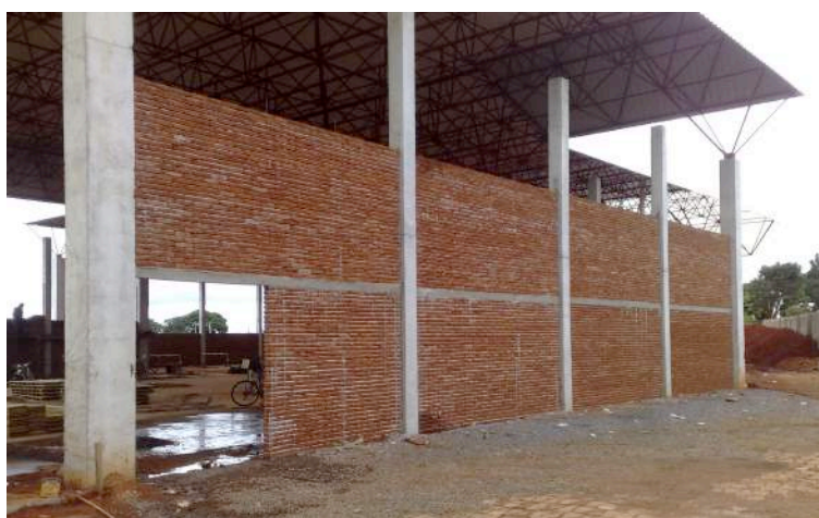
Foto 5 – Tijolo solo-cimento feito com terra do buraco da piscina.
