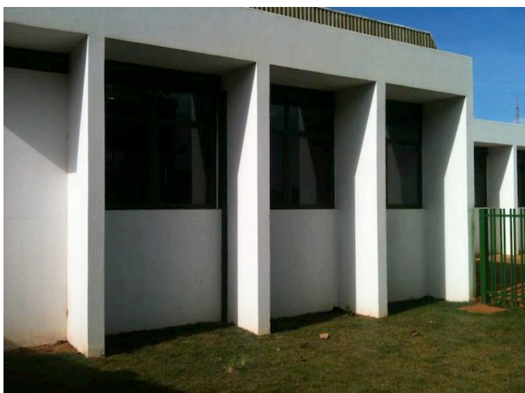
Foto 4 – Fachada Sul do empreendimento: detalhe do brise impedindo a entrada dos raios solares.
